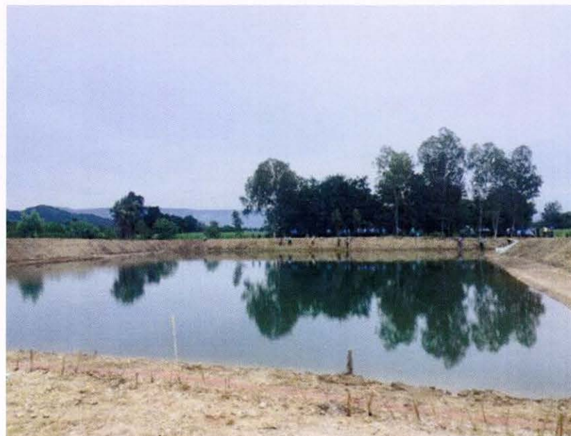
โครงการขุดสระเก็บน้ำ บ้านน้ำอ้อม หมู่ที่ ๓ ตำบลวังหิน อำเภอวังโป่ง จังหวัดเพชรบูรณ์
